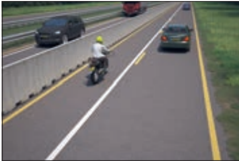
De gele strepen geven aan dat de stroken verlegd zijn. De maximumsnelheid wordt vaak verlaagd en de rijstroken (vooral de linkerrijstrook) kunnen smaller zijn.
